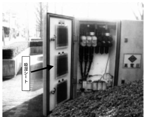
写真1 ドライキーパーの実用例（高圧キャビネット）
