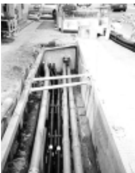
多段配管完了
