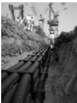
多段配管完了
