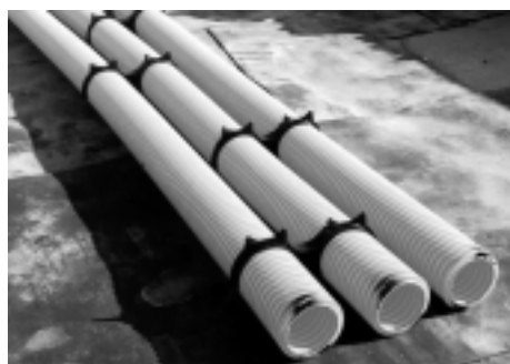
写真7 多条配管施工例 Example of multiple pipe installation
