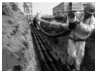
ジェネレックス管敷設状況
