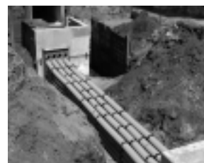
多段配管完了
