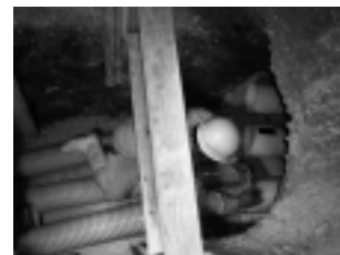
継手作業状況
