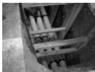
多段配管完了
