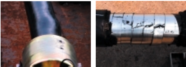
写真2 破壊箇所の状況 Breakdown point of pressure test
