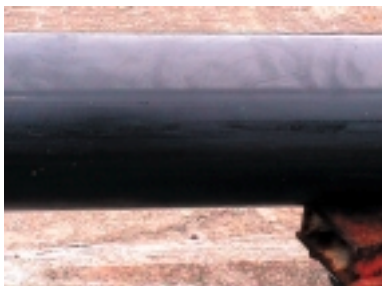
写真9 試験後の外部シース Appearance of outer sheath after laying test
