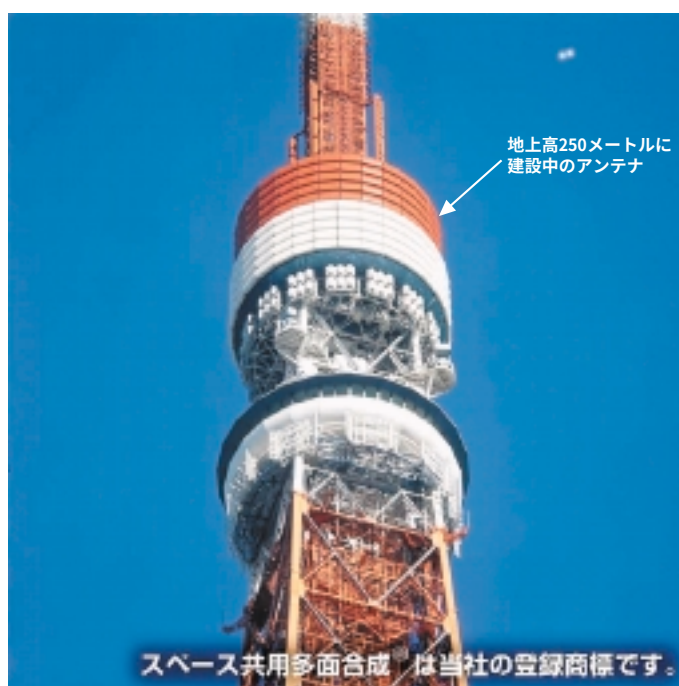
図1 東京タワー（芝）デジタル空中線設備 The Tokyo Tower Antenna Systems for digital broadcast 東京タワーに用いられた当社の優れたアンテナ技術が 認定されました。（特許3374110，特許3374111）
