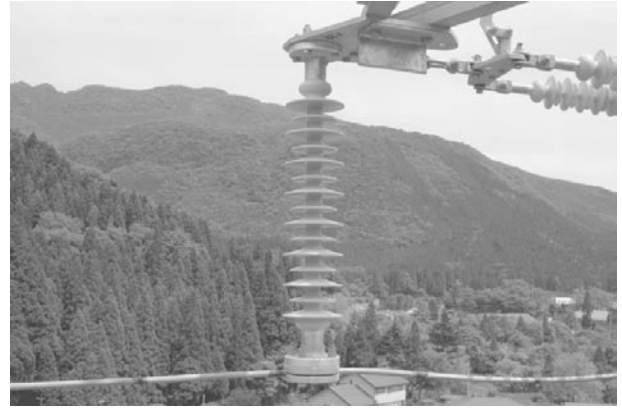
写真3 支持がいし Suspension insulator.
