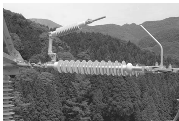
写真8 桜ヶ丘線取り付け状況 Installation situation in Sakuragaoka line.
