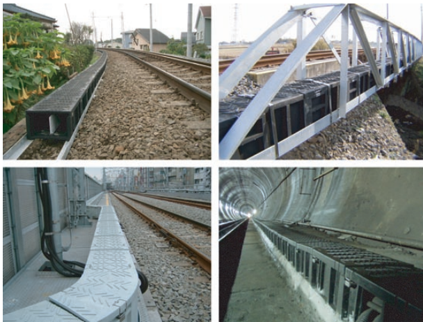
図3 鉄道分野における施工例 Installation example at railroad.
