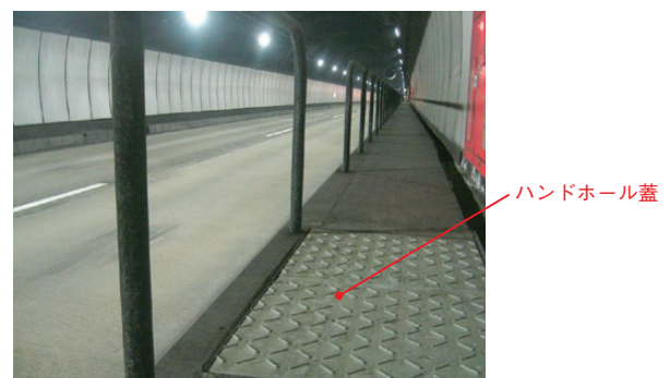
図7 ハンドホール蓋施工例 Installation of environment-friendly handhole cover.
