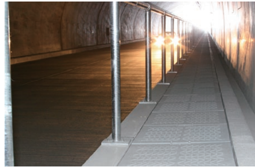
図5 国道トンネルにおける施工例 Installation at a national road tunnel.
