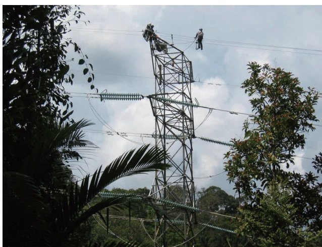
図31 マレーシア TNB275 kV 活線張替え工事状況 OPGW live-line installation for 275 kV power transmission line in TNB, Malaysia.
