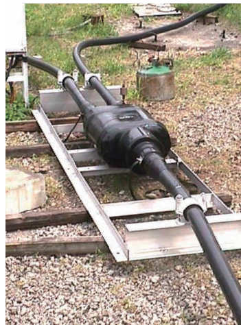
図12 154 kV用コンパクト型Y分岐接続部 (接続部寸法: 300 mm × 600 mm × 1500 mm) 154 kV compact Y-branch joint.
