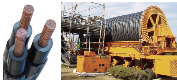
図4 大サイズCVTケーブルの外観とその布設状況 Appearance of large-sized Triplex Type XLPE cable and cable laying.
