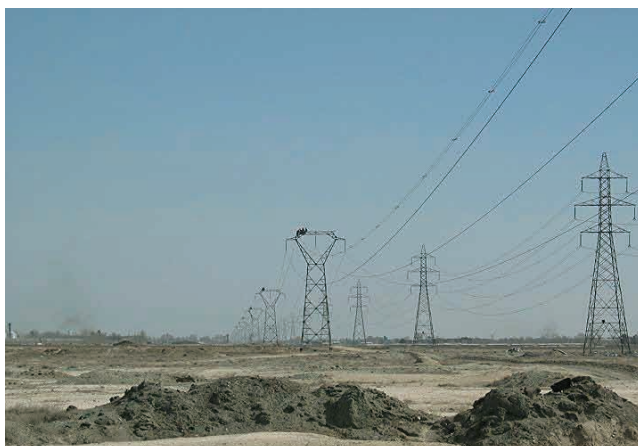
図30 イラン・テヘラン電力220 kV 活線張替え工事状況 OPGW live-line installation for 220 kV power transmission line in Teheran, Iran.
