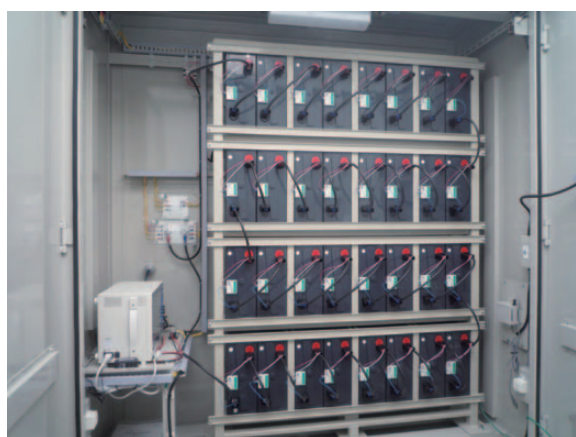
図15 UB100-6 × 32セル 九州ヒューマンメディア創造センター UB100-6 × 32cells Kyushu Human Media Center.
