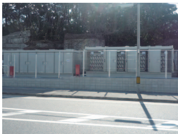
図13 UB1000 × 336セル 前田地区 UB1000 × 336cells Maeda Area.
