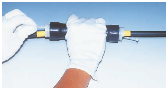
⑦チューブ中央部をしっかりと押さえながら、コア紐を引き抜きます。
