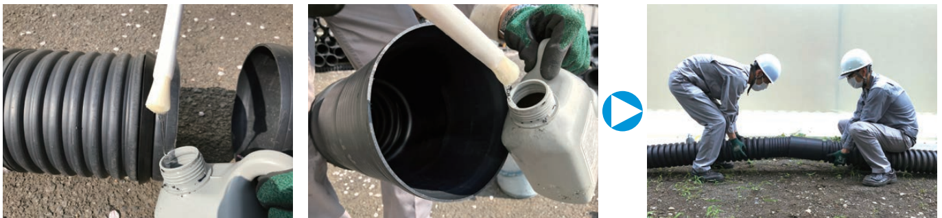
オス側継手のパッキンと、メス側継手の内面に滑材を塗布
