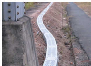
●障害物を回避した施工例
