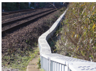
●不陸に追従した施工例
