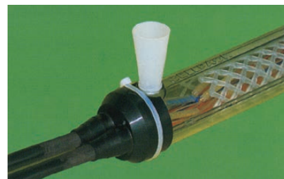
③ 分岐アダプタをケースにしっかり挿着、締付バンドで固定し、レジン注入します。分岐アダプタとケーブルに隙間がある場合はレジン流出防止としてテープで端部を押さえ巻きしてください。
