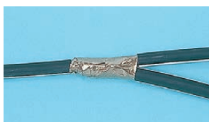
②耐火テープを巻きます。
