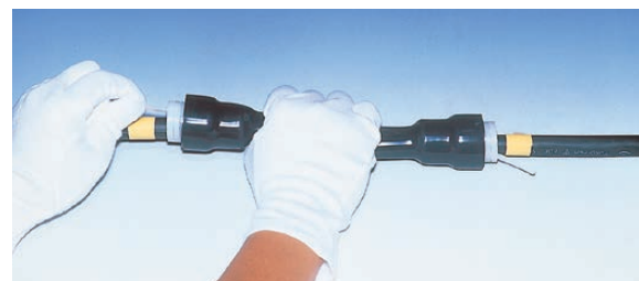
⑤マーキング部にブルフィットチューブを合わせ、コア紐を引き抜きます。
