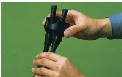
① 分岐アダプタをケーブル外径より約2mm小さ目の内径で切断し、ケーブルを挿入しておきます。
