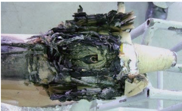
図7 タイプAケーブルコアの損傷の様子 The damage appearance of the cable core of the type A.
