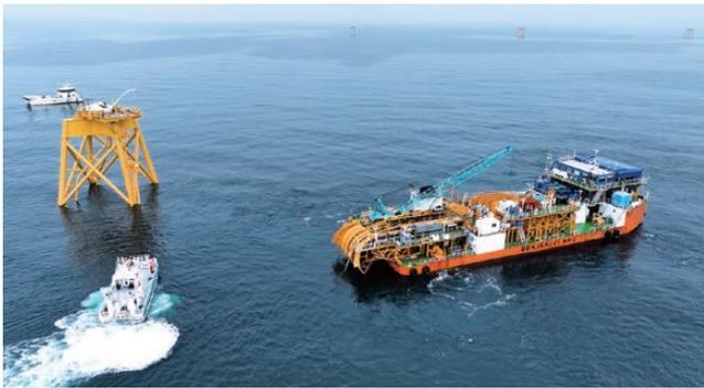
図6 海底ケーブルの風車への布設
