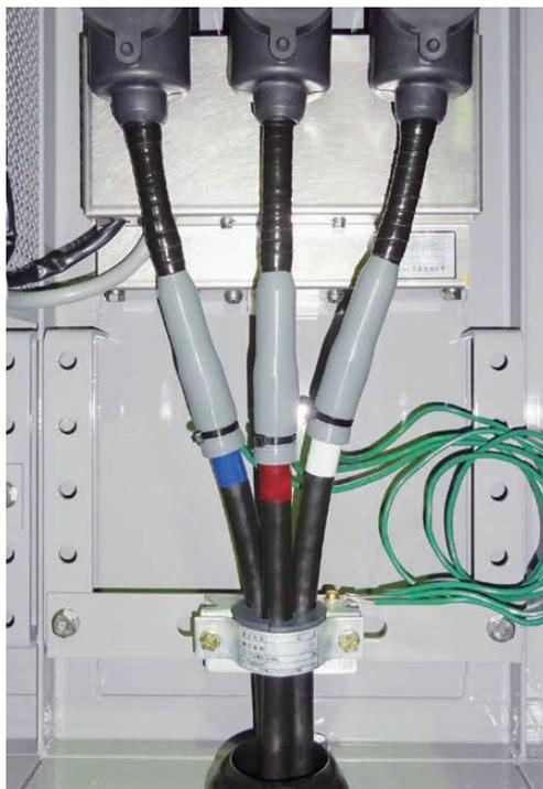
図7 開閉器内施工例（アイヒットニュー TS6）
