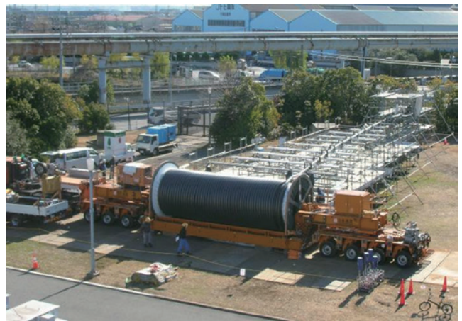
図4 長尺ケーブル布設 Installation of the ultra-long power EHV cable.
