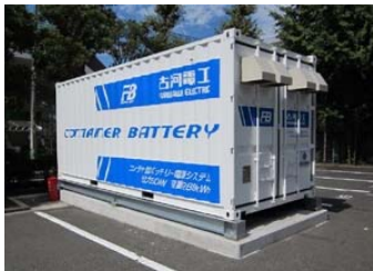
パッケージ型蓄電池システム
