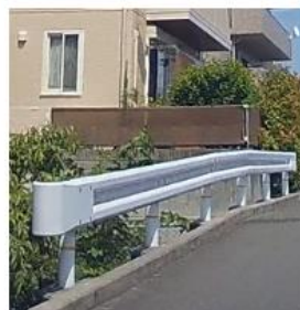
ガードレール
