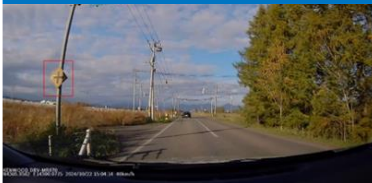
曲がった道路標識：1基
