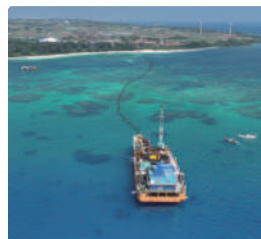
海底送電システム (海底電力ケーブル納入および布設工事)
