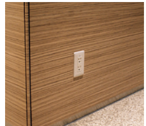
災害時にV2B+Liイオン蓄電池から電力供給される1Fコンセント
