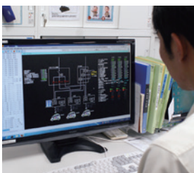
コントロールセンター内のオペレーション画面。EVも表示される。
