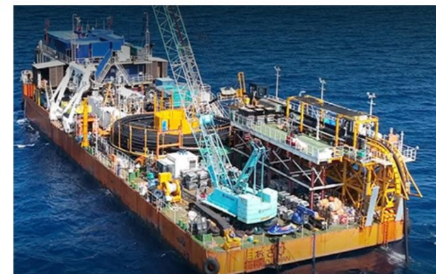
本案件の海底送水管積み込み風景
