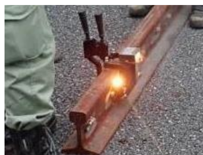
銅テルミット溶接施工風景
