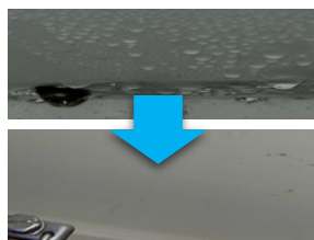
結露防止状況
