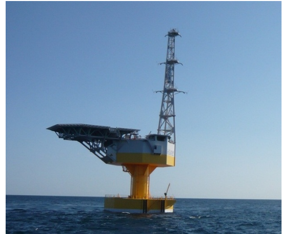
66kV 浮体式洋上サブステーション「ふくしま絆」 (浮体形式：アドバンストスパー)
